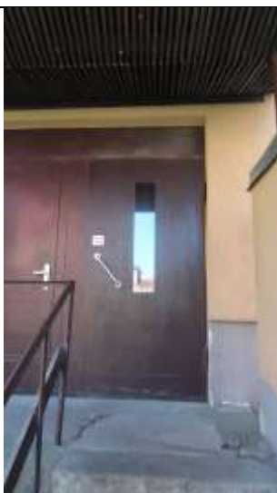
Kāpņu telpas ārdurvis
